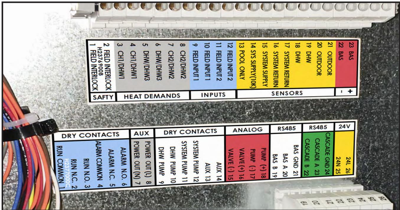
Figure 24. Borniers d'entrée et de sortie Branchements basse tension / câblage sur site
