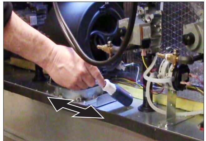
**Figure 41. Régler le taux de CO<sub>2</sub> au niveau du volet d'air**
