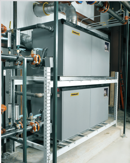
Gain de place, les chaudières Pennant peuvent être empilées avec le système de contrôle intuitif Laars Linc.
